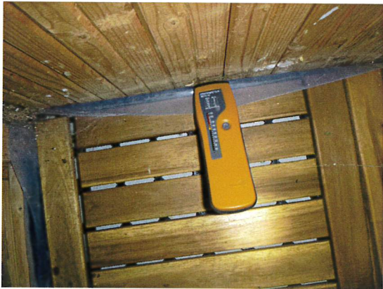
Fuktmätning i nederkant av utreglad vägg.
