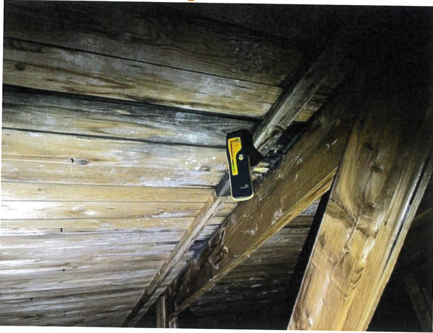
Fuktmätning på vind.
